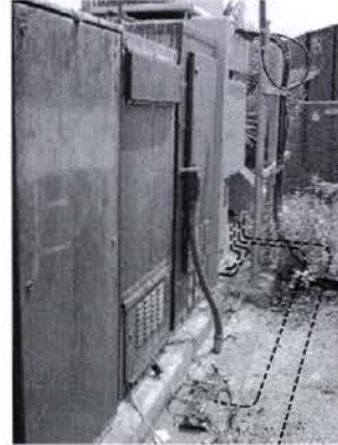
TWC (N) CONDUIT ROUTING
