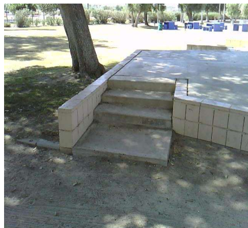
Stairway , Risers Striping : No Riser Striping
